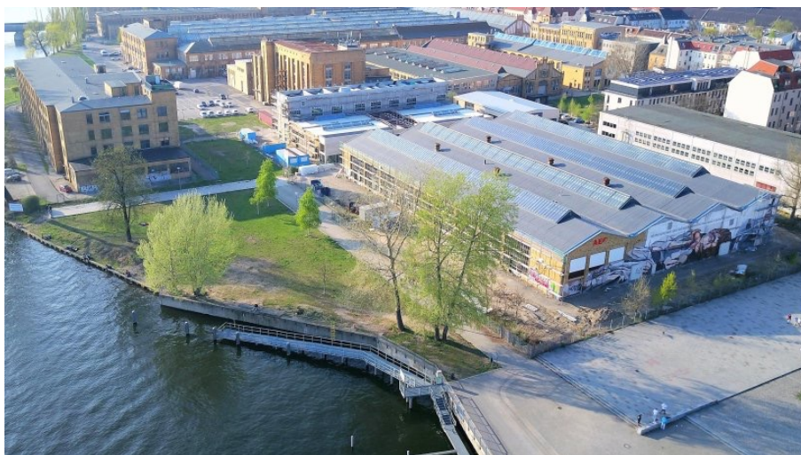
Kunstquartier Reinbeckhallen; die weiße Betonhalle (r.) will der Künstler Olafur Eliasson ausbauen
